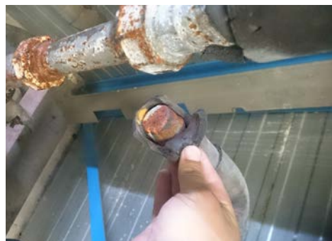
Corrosie onder isolatie is een sluipende vijand. Thermisch isolerende nanocoatings maken metalen extreem anti-corrosief.
