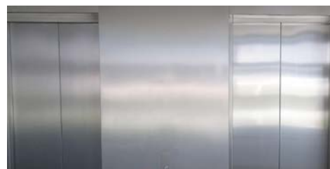
De linker liftdeur is niet behandeld, de rechter liftdeur staat hier een jaar in de nC ProTect 4600 sealant. Meer kleurdiepte, maar vooral meer bescherming tegen krassen en vervuiling maakt het verschil. (Foto: nC Marine)
